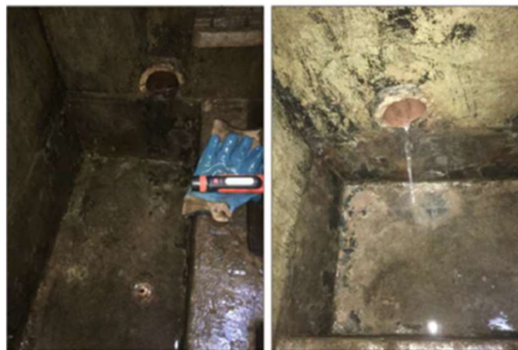
Obrázek 7: Šachtice II stav po čištění
