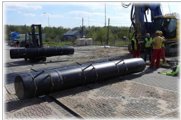
Obr. 2 a 3: Použití centrátorů na plastové zárubnici typu PEHD
