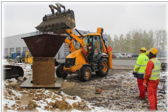
Obr. 4 a 5: Provádění štěrkového obsypu a těsnícího můstku
